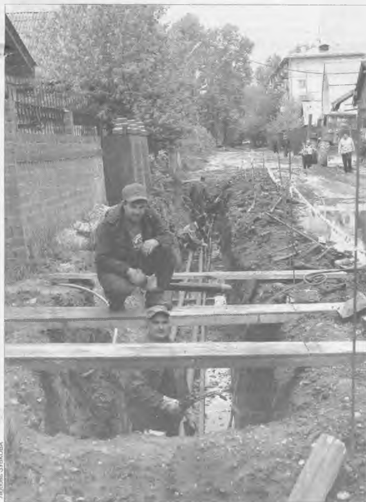
Улица Пархоменко в поселке Байкальский. Здесь ремонт теплотрассы осложнен тем, что в одном лотке одновременно проложены теплосети и водопровод
