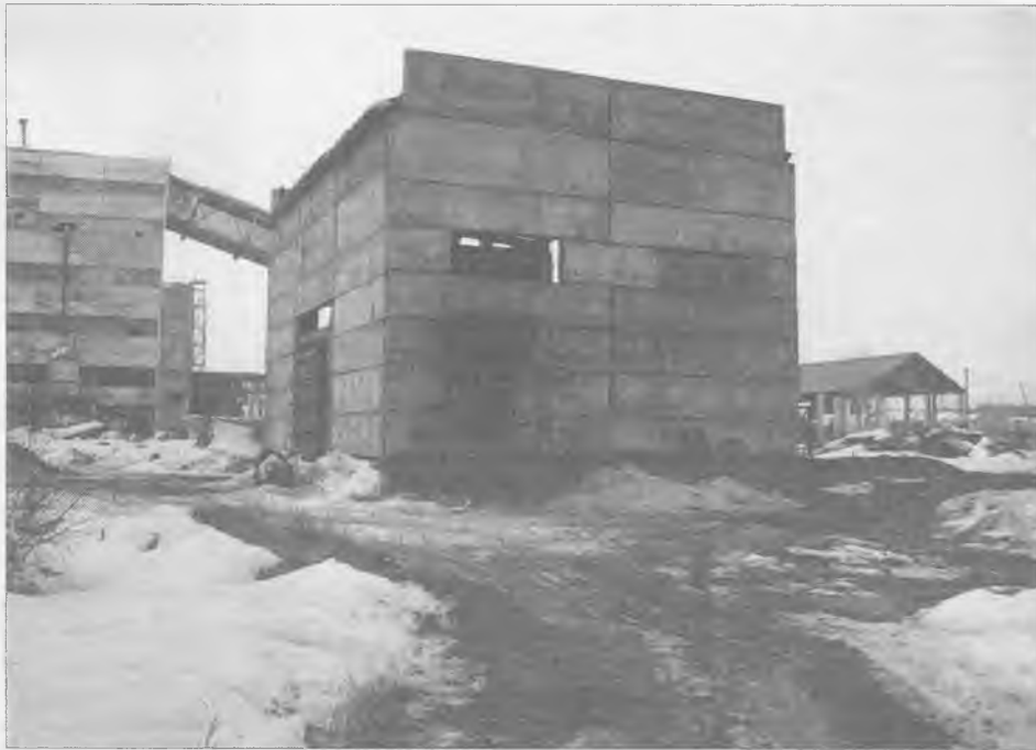
В этом неприметном цехе было размещено нелегальное производство по переработке похищенной нефти
