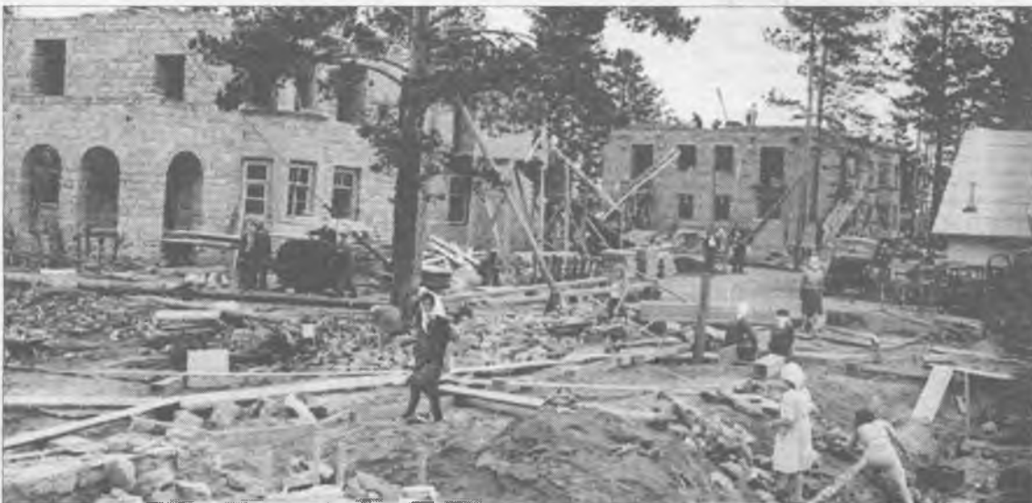
Первая половина 1950-х: строится Соцгород. Мужчины - у механизмов, женщины - с тачками и носилками
