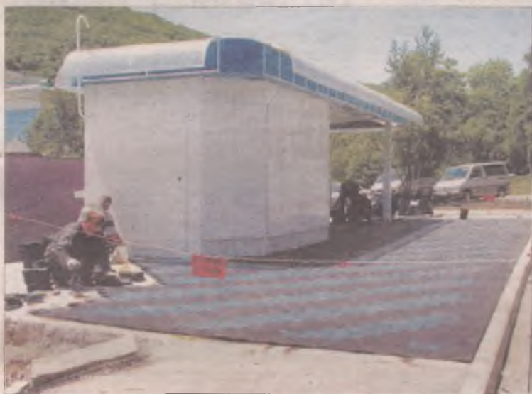
Резиновые плитки укладываются по той же технологии, что и бетонная брусчатка
