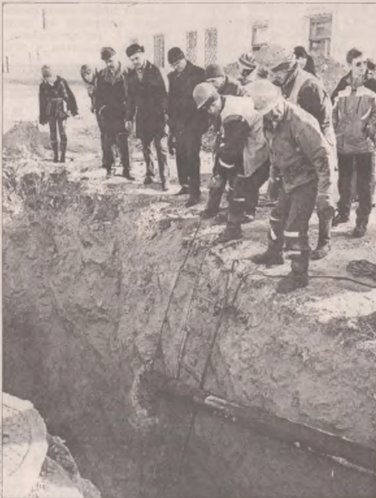
Специалисты «Ангарского Водоканала» испытывают новое оборудование на замене изношенных коммуникаций в старой части города
