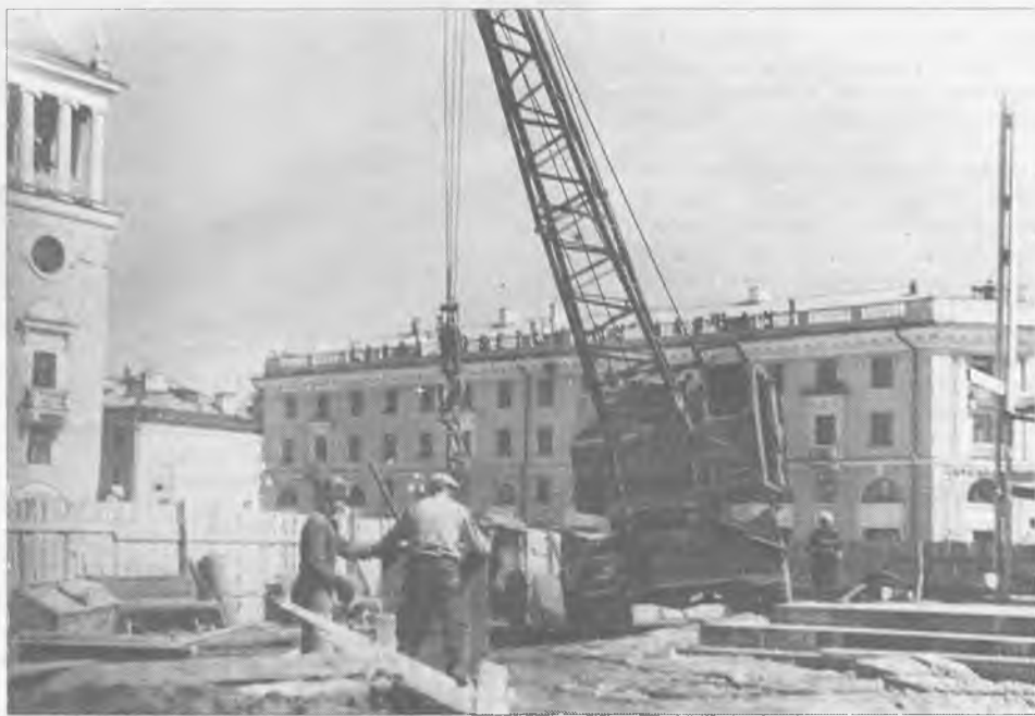
Кажется, что Ленин на площади стоял всегда, как и здание мэрии. Ан нет! В 1953 году здесь ещё вовсе велось строительство
