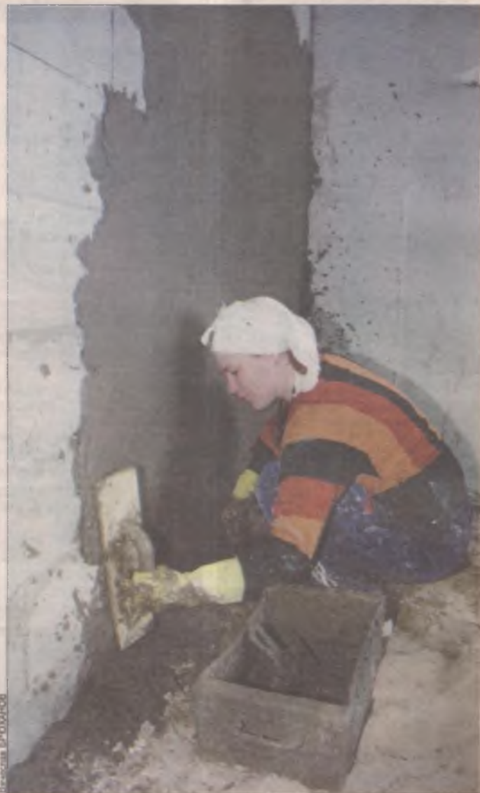
Сейчас в доме ведутся работы по внутренней отделке. Ее с любовью делают красивые девушки
