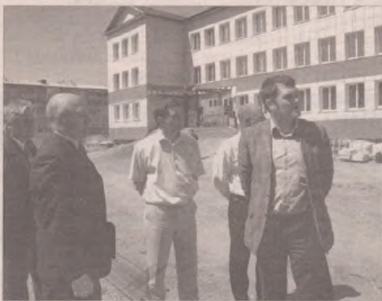
Строительство школы в 7 микрорайоне идет по правилу: всё лучшее - детям
