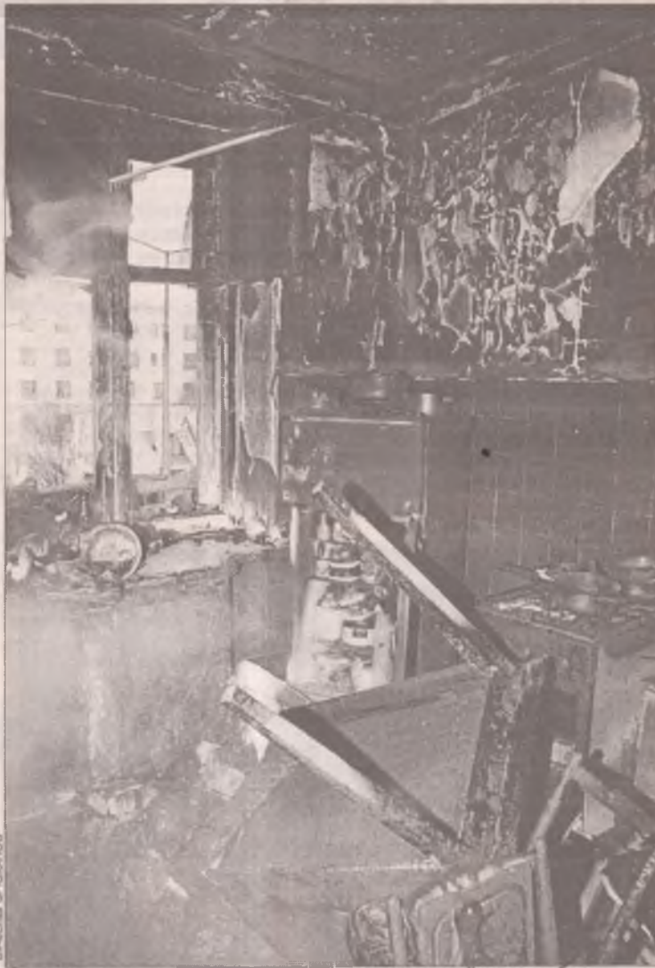
Очаг пожара, находившийся на захламленной кухне, был ликвидирован через полчаса после вызова
