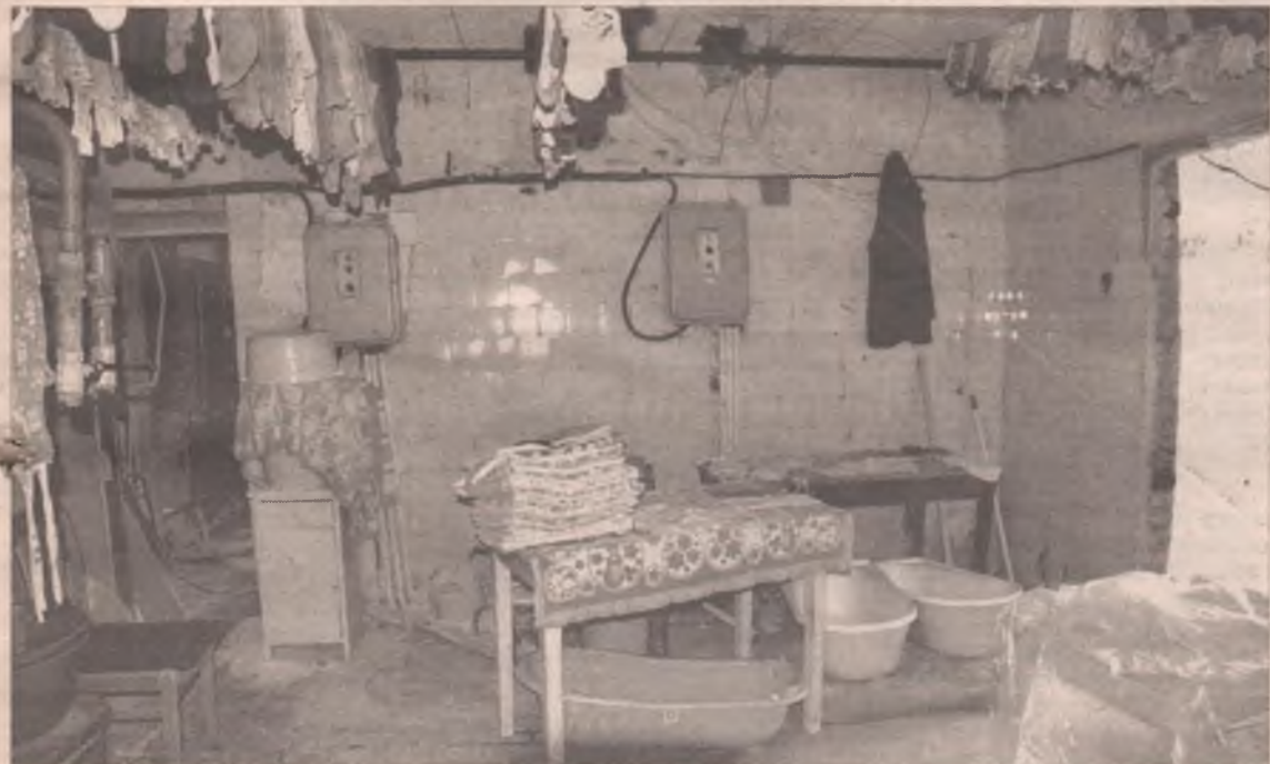
Прачечная дома ребенка в 47 квартале: трубы давно просятся на пенсию, проводку нужно заменить - иначе короткого замыкания не избежать
