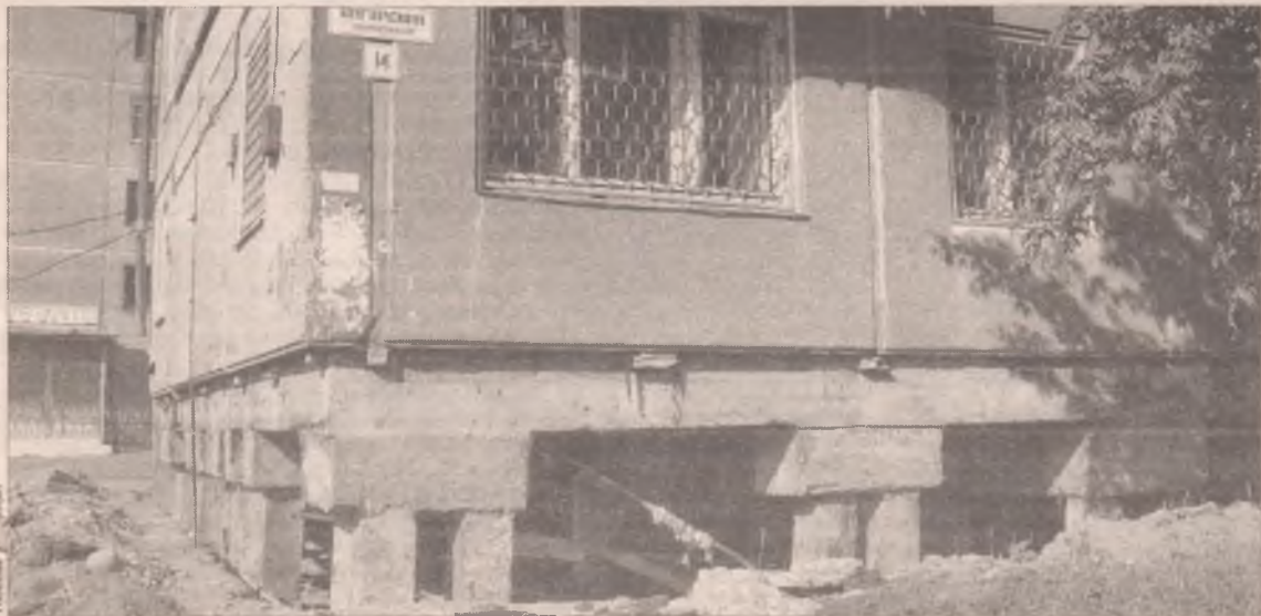
Старые плиты в утиль, а дому новую одежду
