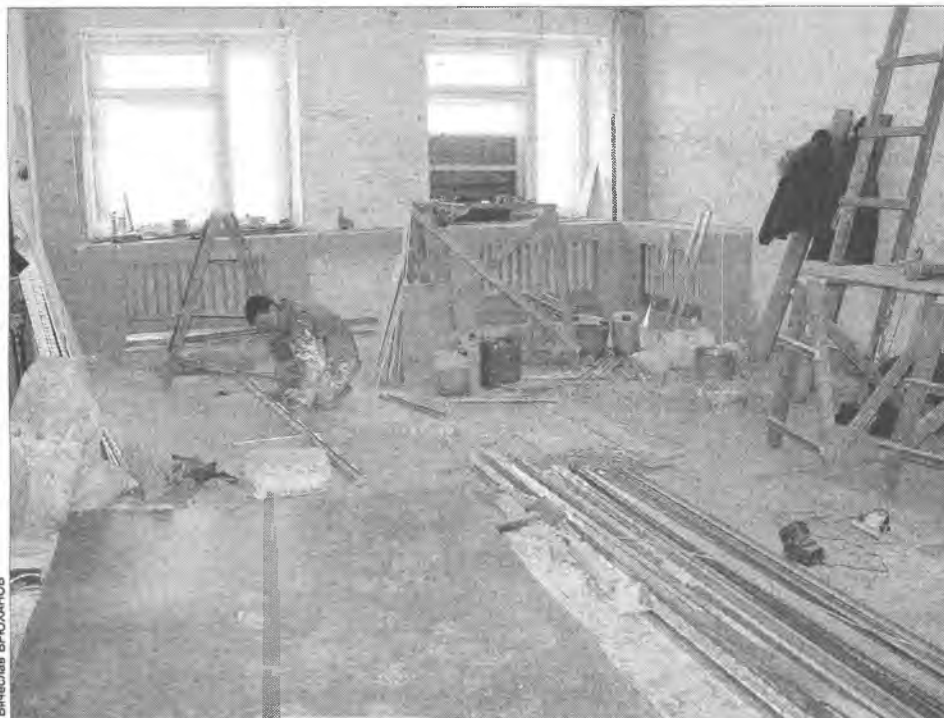
28 муниципальных учреждений дождалось капитального ремонта
