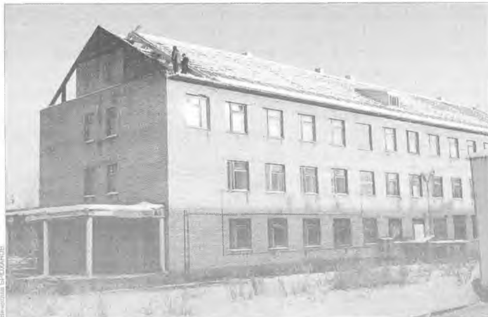
В детской поликлинике №4 в 12а капитальный ремонт в разгаре
