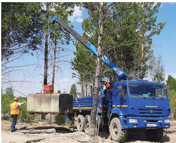
• На строительной площадке
