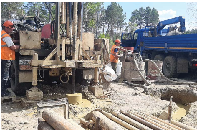
• Изыскательские работы. Бурение скважин
