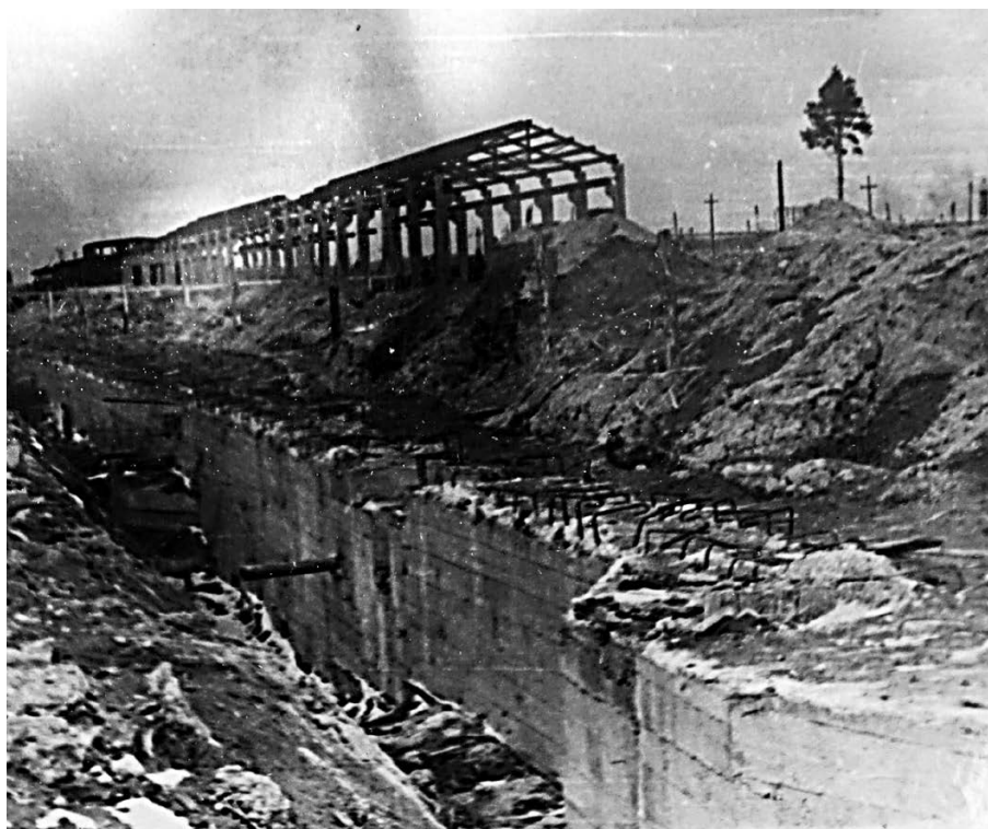
• 50-е годы XX века, снимок части строящегося Комбината-16. На первом плане траншея. Фото из архива Музея трудовой славы АНХК.
