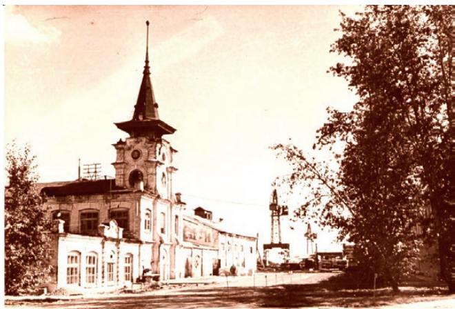
• Башня спичфабрики, 1970-е
