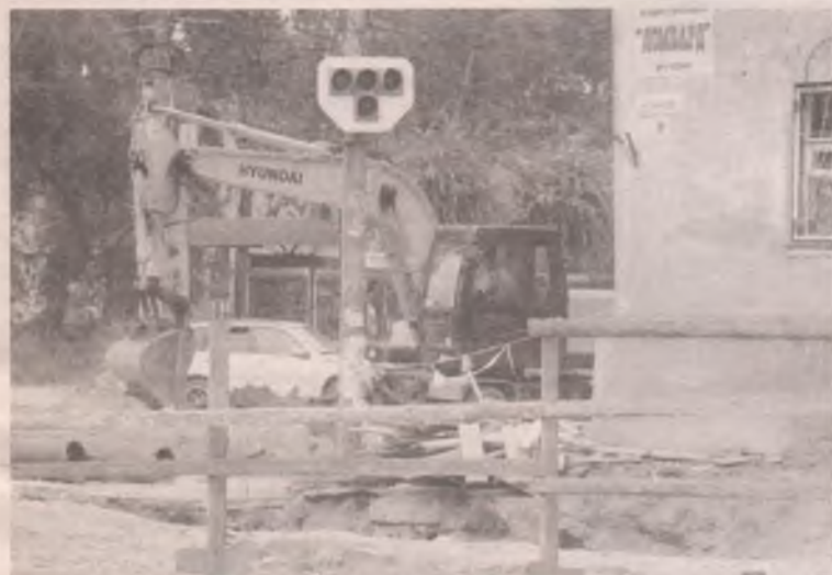
Почти там же, но это уже идет ремонт теплотрассы. Наверняка ангарчане, жители близлежащих кварталов, не обидятся на временные трудности.
