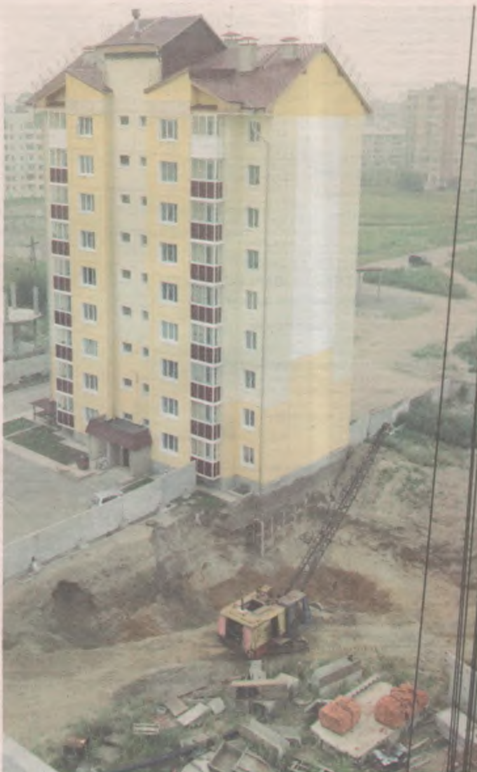
РАЗРАБОТКА КОТЛОВАНА 19 ДОМА, СЕКЦИИ 2,3 В 32 МИКРОРАЙОНЕ
