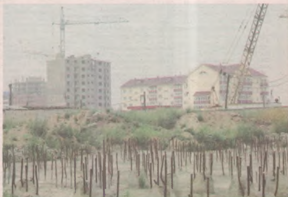
СВАЙНЫЕ ПОЛЯ 16 ДОМА В 32 МИКРОРАЙОНЕ. ПЕРСПЕКТИВА 2014.
