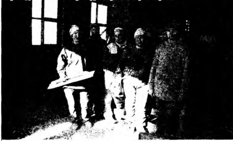
Мастера «чистовых» работ. Бригада маляров-штукатуров треста «Промстрой».
