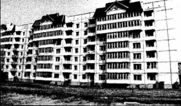
Строится дом №8 в 32 мр-не.
