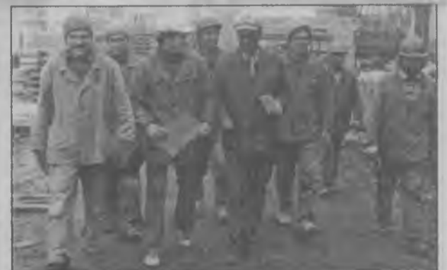
Группа монтажников СМУ-1 во главе с бригадиром М.И.Стариковым на строительстве 19 микрорайона. Эта бригада монтировала все девятиэтажные дома серии И-163-02.
