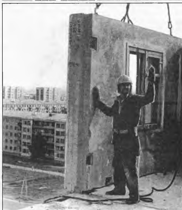
Строительство девятиэтажного дома "Олимпиада-80" ведет бригада монтажников СМУ-1 Михаила Ивановича Старикова, помощник бригадира Александр Долженков, июнь 1977 года.
