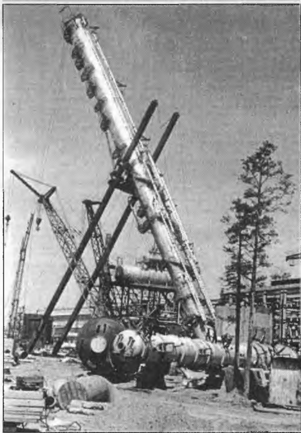
Подъем-монтаж третьей технологической колонны на строительстве аммиака-карбамида СМУ-3, 23 мая 1981 года.
