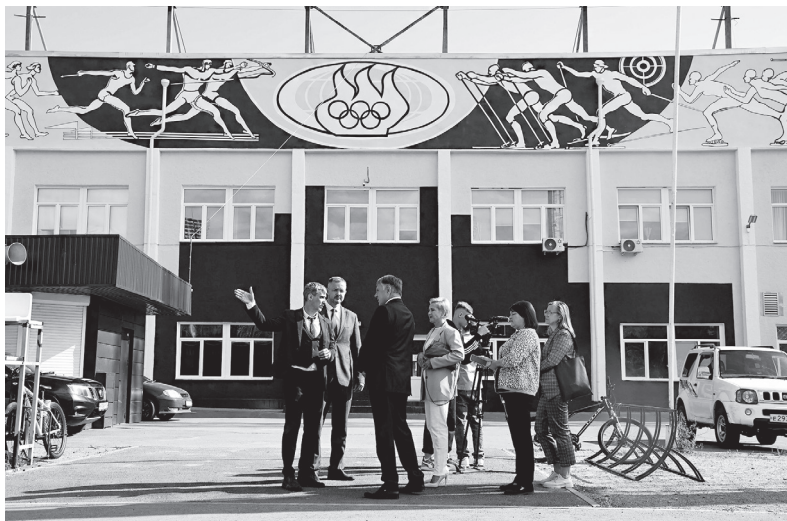
■ На фасаде стадиона «Ангара» полностью восстановили историческую фреску
