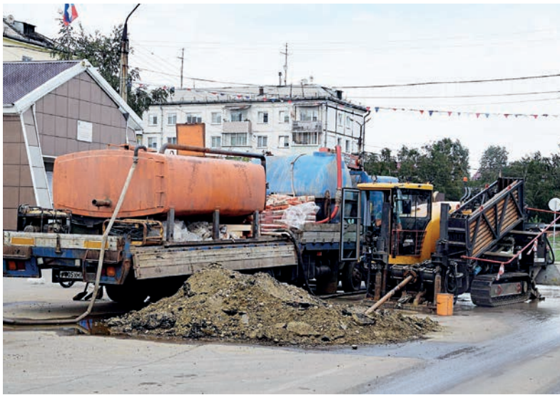
■ На улицах Мегета проводится замена трассы теплоснабжения. Это позволит бесперебойно обеспечивать посёлок теплом и подключать дополнительные объекты
