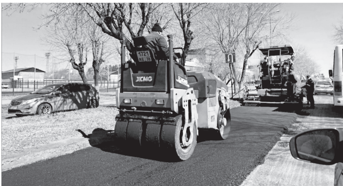
■ Надёжность ремонта большими картами значительно выше, чем у ямочных заплат. Кроме того, эта технология позволяет охватывать более крупные участки дорог
