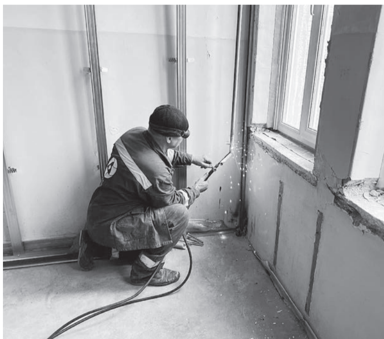
■ Блок «В» Ангарского перинатального центра капитально ремонтируется: меняют полы, сантехнику и электропроводку, облицовку стен
