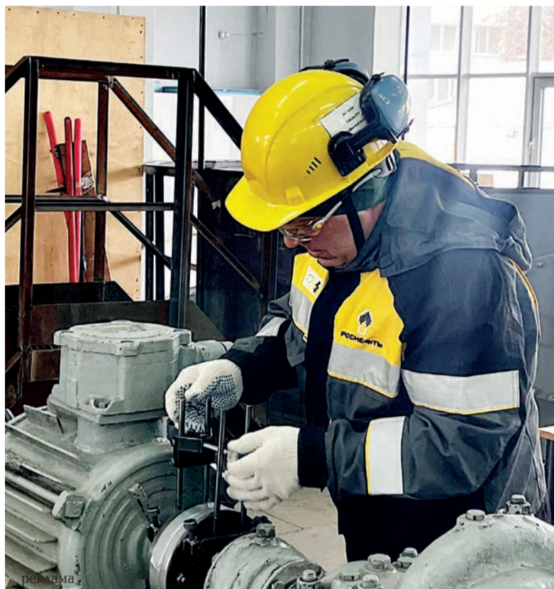
■ Профессионализм и большой опыт Дмитрия Семейкина помогли ему войти в тройку лучших слесарей по ремонту технологических установок машинного оборудования АНХК
