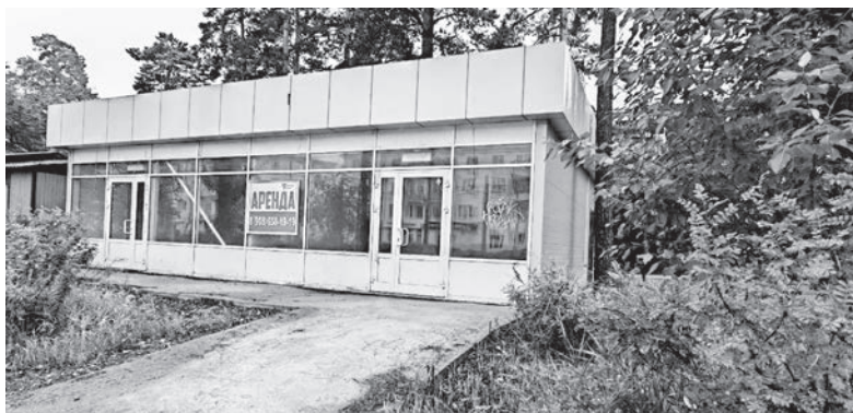
■ Продолжается работа по демонтажу не соответствующих требованиям или давно не используемых торговых объектов
