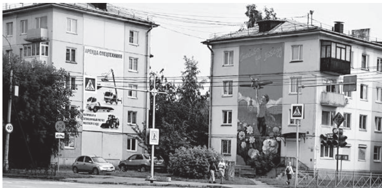
■ Баннеры на фасадах домов нарушают Правила размещения и содержания рекламных конструкций
