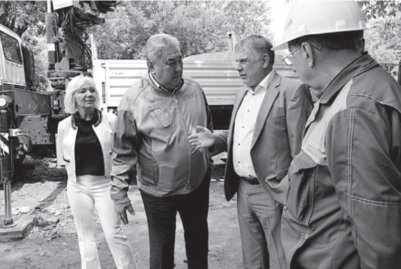
■ Рабочая поездка мэра округа Сергея Петрова началась с улицы Горького, где производят замену трубопровода холодного водоснабжения. Далее молодёжный центр «Театральный» встретил гостей обновлённым фасадом. Последняя точка выезда - вторая очередь берегоукрепления реки Китой
