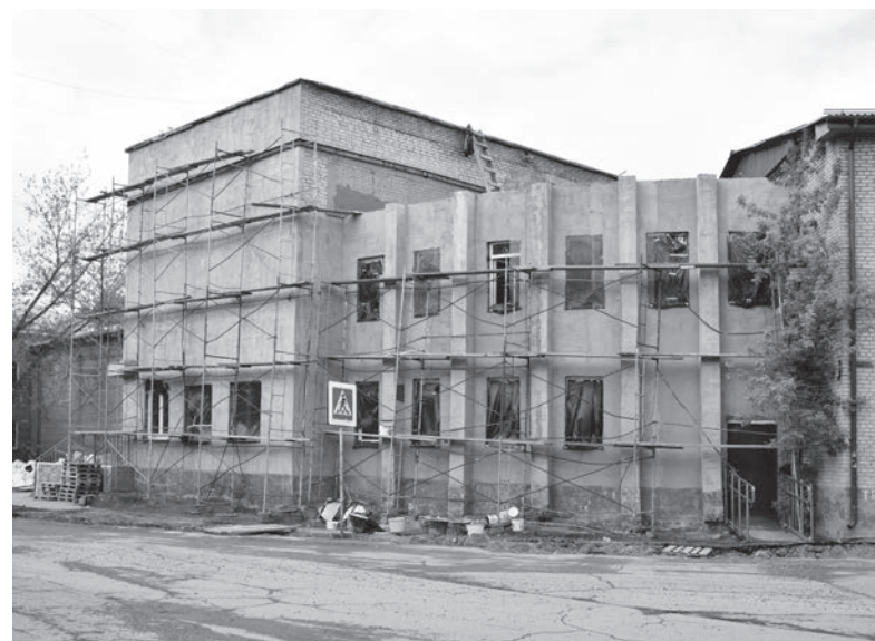
■ В будущем молодёжном центре приводится в порядок фасад. Во всём здании установлены новые оконные блоки. Сейчас ведётся замена вентиляции, систем отопления, водоснабжения, канализации
