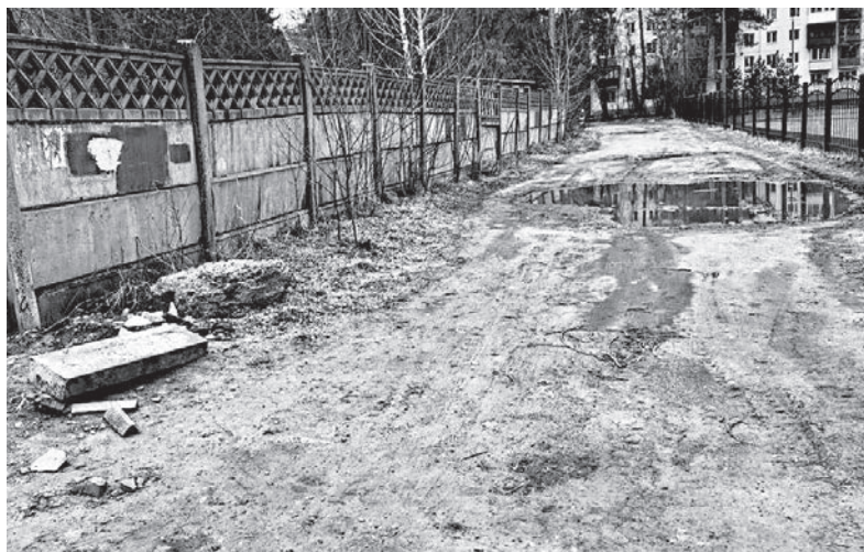
■ В этом году планируется благоустройство пешеходной зоны между школой №3 и детским садом №71. Сейчас эту территорию одновременно используют ребята и автомобилисты. Для безопасности детей будет оборудована пешеходная дорожка и смонтировано освещение
