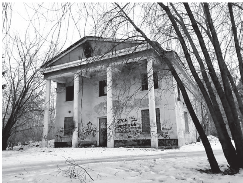
■ Пока здание Дома культуры заперто на ржавый замок, окна заложены кирпичом, стены изрисованы вандалами, а в том месте, где когда-то был пристрой, успели вырасти деревья
