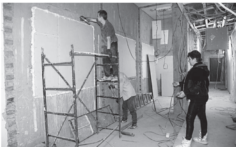
■ В этом году в помещениях объединения, помогающего реабилитации людей с ограниченными возможностями здоровья, завершится капитальный ремонт
