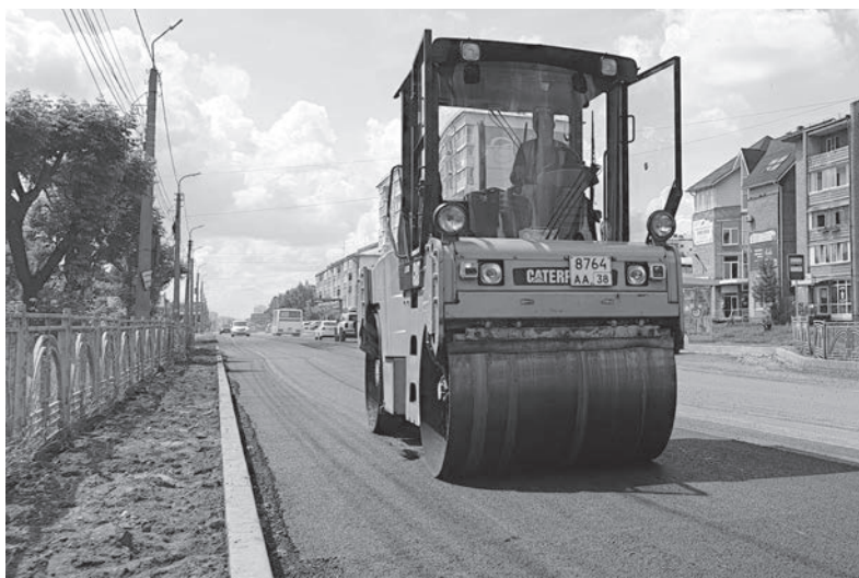
■ На Ленинградском проспекте проведён ремонт от улицы Красной до Горького с заменой трамвайных путей на трёх перекрёстках. Эти пути не обновлялись с 1989 года, когда было начато движение вагонов по улице Социалистической
