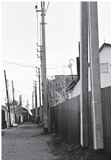
■ В 2022 году в «Преобразователе природы» выполнены работы по замене деревянных опор на железобетонные
