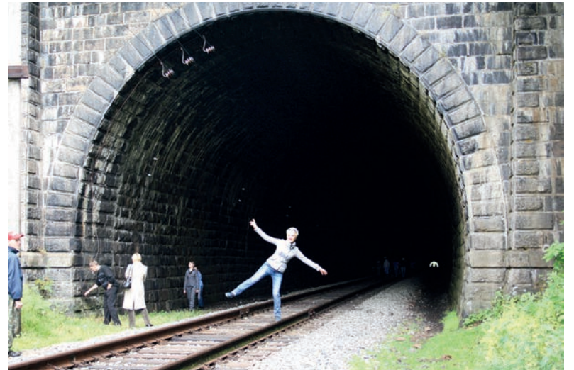
■ На КБЖД используется 38 тоннелей общей длиной 9063 метра
