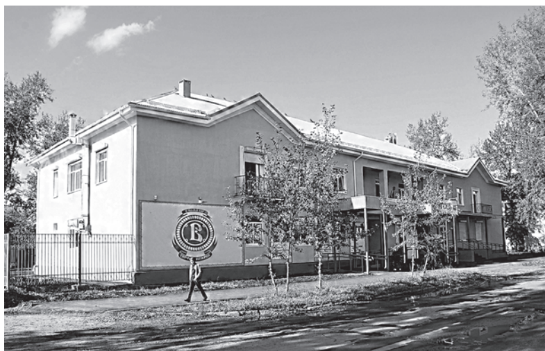
■ От старого здания остались только стены. Строители отремонтировали кровлю, установили новые окна и двери, заменили системы водоснабжения
