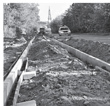
■ На улице Связи идёт строительство тротуара
