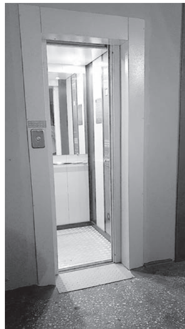
■ У нового лифта масса достоинств: повышенная плавность и бесшумность хода, система защиты от неконтролируемого движения кабины
