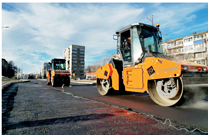
■ Строительство участка второй полосы улицы Социалистической позволило существенно повысить пропускную способность в юго-западной части Ангарска
