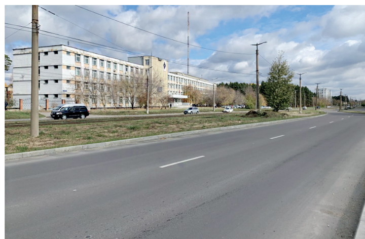
■ Выполнен финальный этап ремонта улицы Чайковского - от улицы Крупской с расширением проезжей части на пересечении с улицей Троицкой
