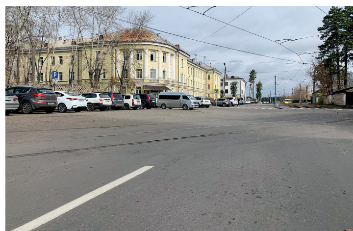
■ Улица Чапаева на участке от улицы Иркутской до МСЧ-36 давно нуждалась в ремонте. Здесь обновили проезжую часть, расширили парковочные карманы и заменили более 100 метров трамвайных путей
