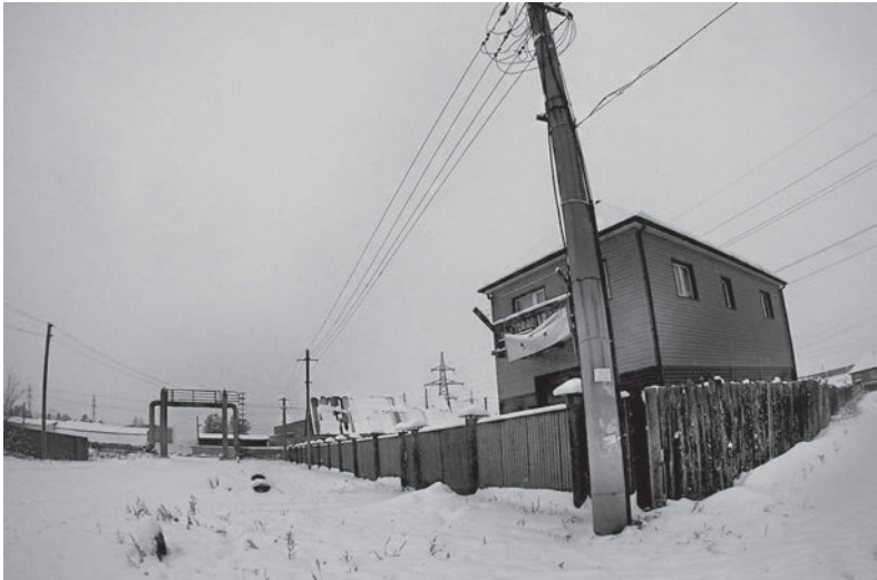
■ Причиной аварии назвали повреждение подземной кабельной линии. В настоящее время «Братские электрические сети» проводят ремонтные работы на электросетях
