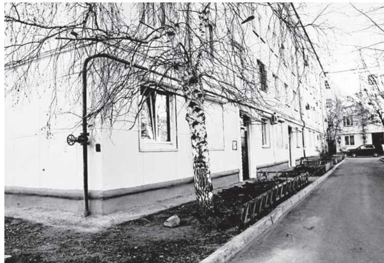
■ В доме 1 в 89 квартале подрядчик практически завершил обновление фасада и замену окон. А компания, ответственная за ремонт теплоснабжения, со своей задачей не справилась. Сейчас ведётся работа по расторжению договора
