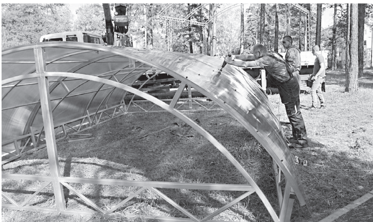
■ Новая сцена внутри ангарских дворов появится впервые, установят её в 82 квартале. Крыша почти готова к монтажу
