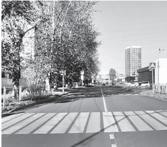
■ Для безопасности пешеходов перенесены переходы и установлены искусственные дорожные неровности
