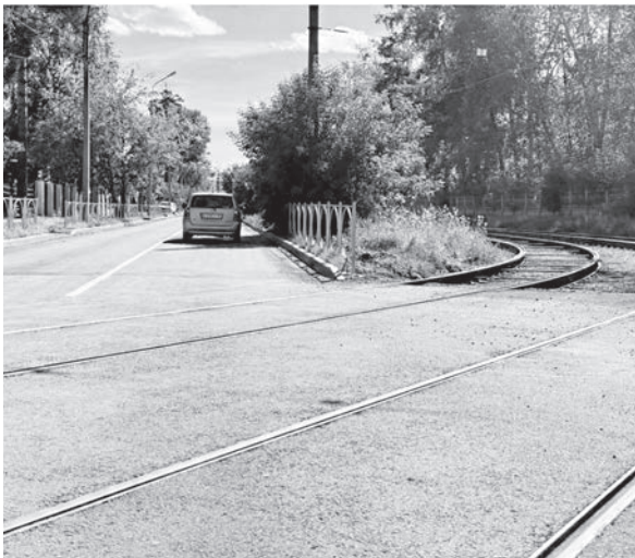
■ Сложной задачей для дорожников стала замена рельсов на улице Чапаева - изогнутые пути для вагонов делали по спецзаказу
