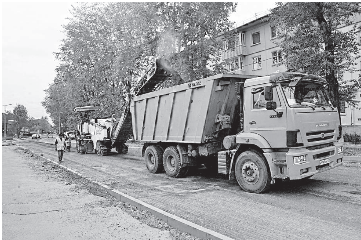
■ В этом году ремонтируют улицу Фестивальная. Долгое время здесь в особенно плачевном состоянии находился участок дороги в районе школы №37. Вместе с проезжей частью обновляются тротуары, а также появляются островки безопасности для пешеходов
