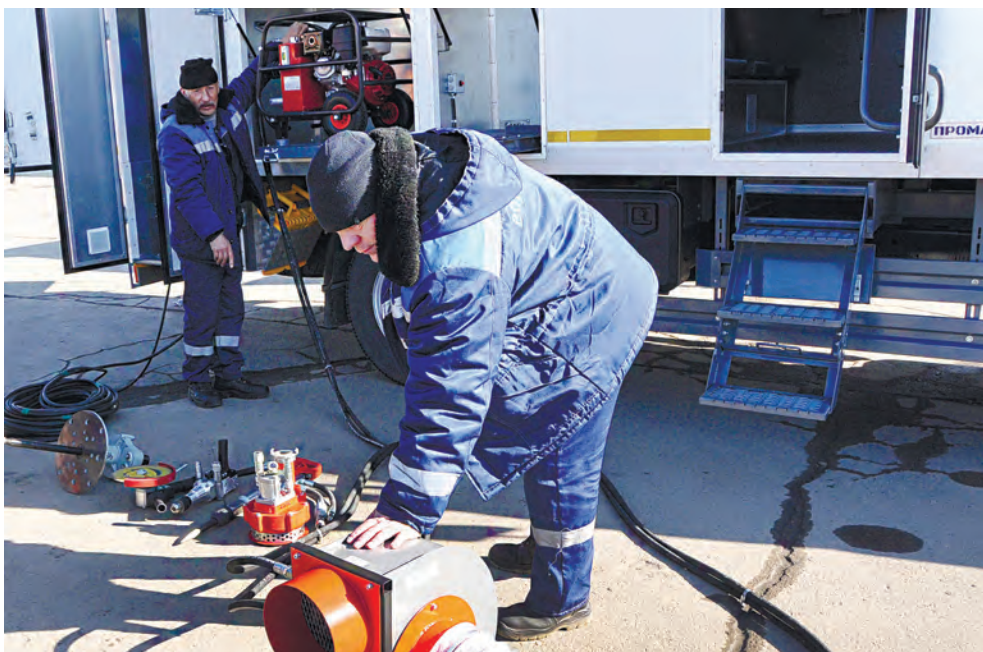
■ Вся спецтехника питается не от электрики, а от гидравлической станции, что крайне важно для обеспечения безопасности при работе в колодцах
