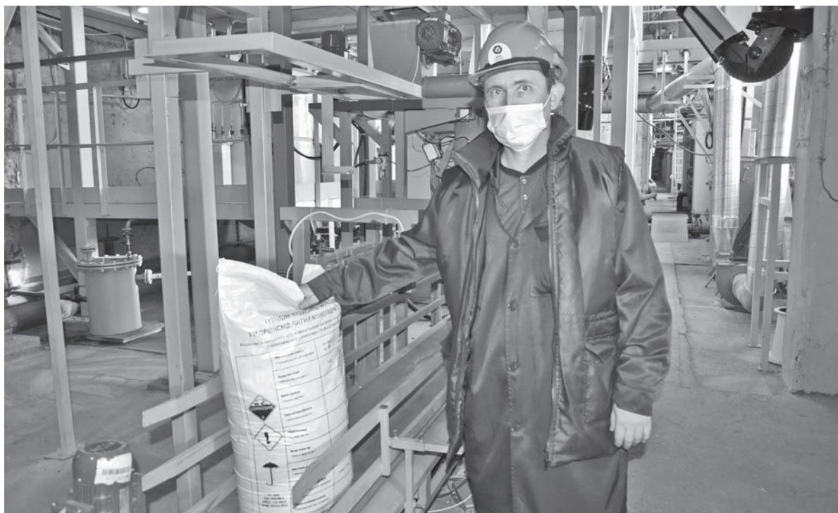
■ В АО «АЭХК» активно развиваются неядерные бизнесы. В этом году запущена опытная установка по производству гидроксида лития
