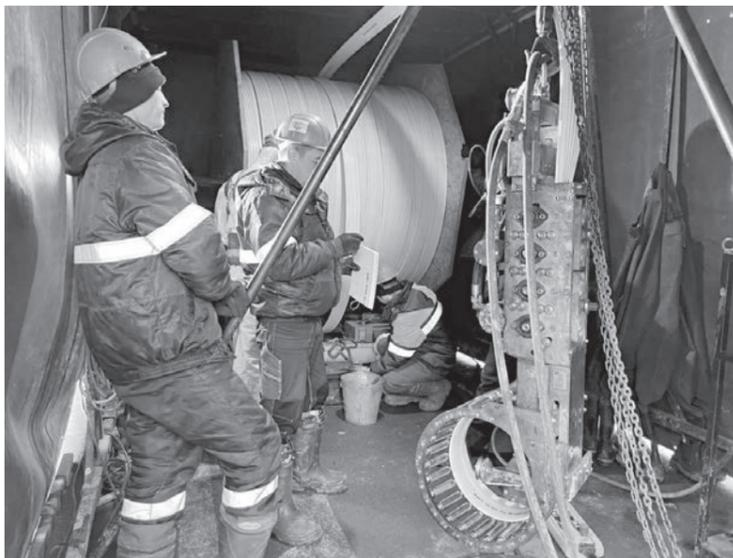
В этом году ремонт канализационных коллекторов «Водоканал» проводит спирально-навивным методом
