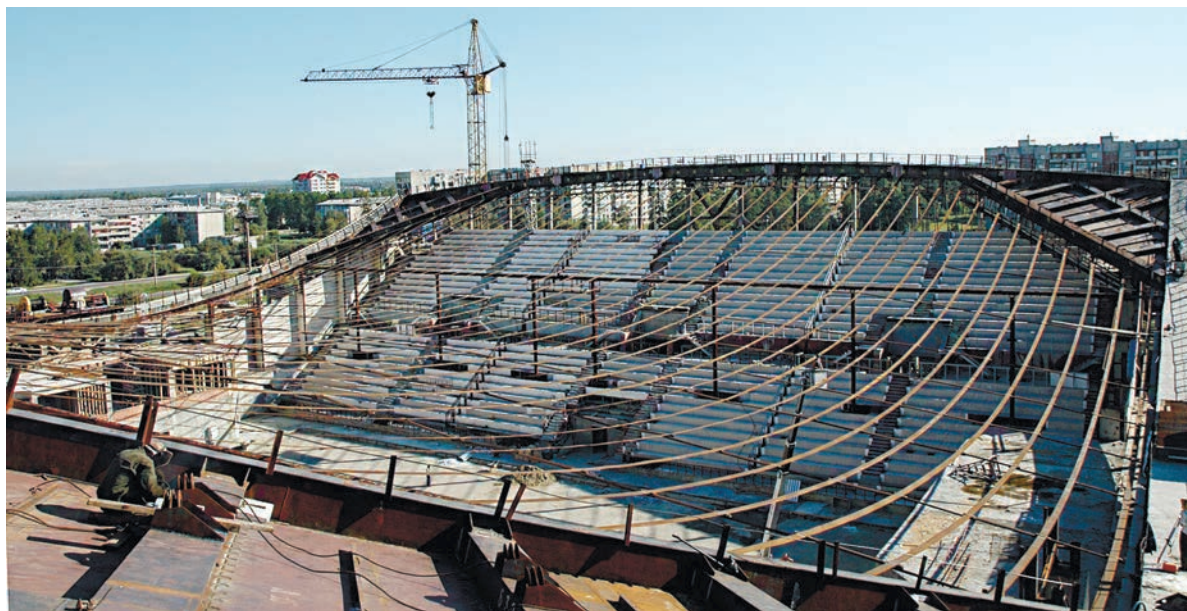
■ Реконструкция «Ермака» началась в 2003 году. Она включала в себя строительство крыши вогнутой формы. Для этого была применена уникальная мембранная конструкция. Мембраны обеспечивают высокую устойчивость крыши к перепадам температур
