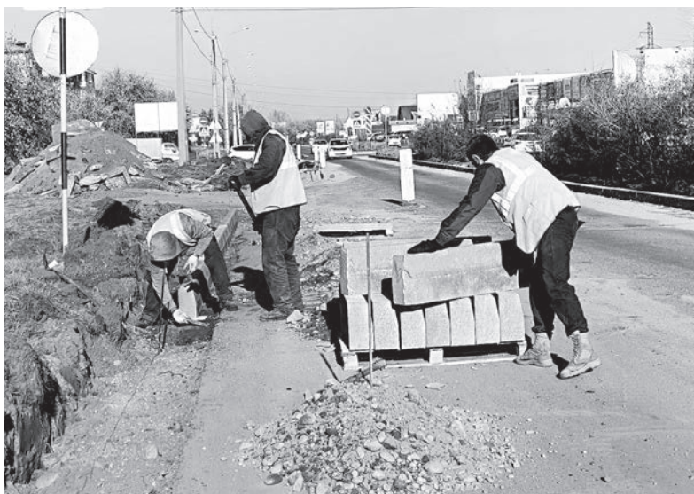
■ Благодаря заранее подготовленной проектно-сметной документации администрация смогла привлечь дополнительное финансирование. На эти средства ведётся ремонт завершающего участка улицы Декабристов с выполнением выезда на дорогу АЭХК
