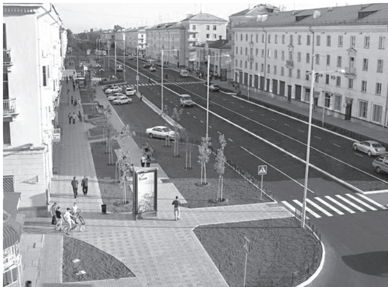
■ 31 августа после масштабной реконструкции было открыто движение по обновлённой улице Карла Маркса
