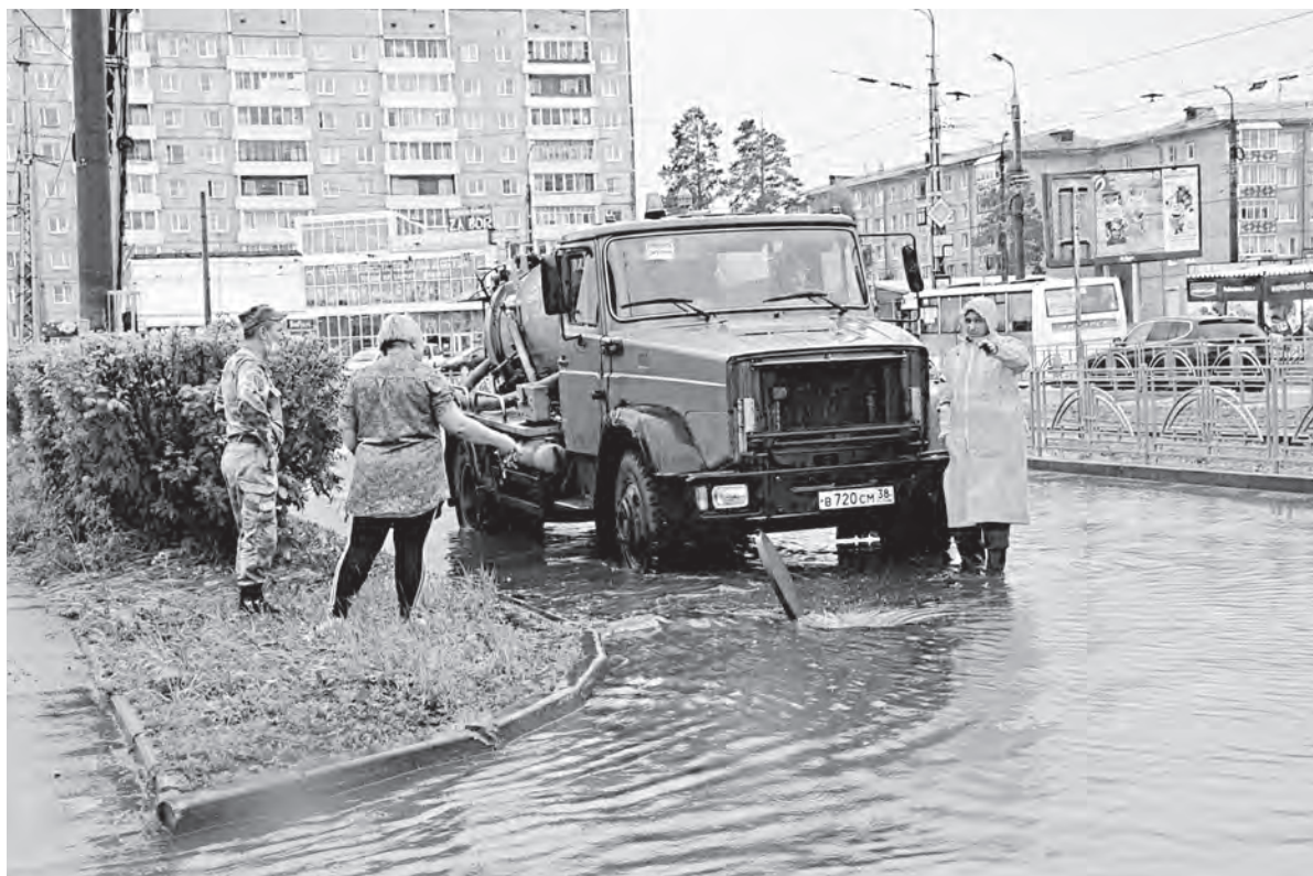
■ В нынешнее дождливое лето предприятие «Ангарский Водоканал» работало оперативно по устранению последствий ливней и ремонту ливневой канализации
