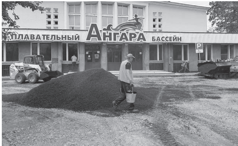
■ Ремонт внутри помещений начнётся ближе к холодам. Пока есть возможность, подрядчик выполняет работы по благоустройству территории и обновлению фасада
