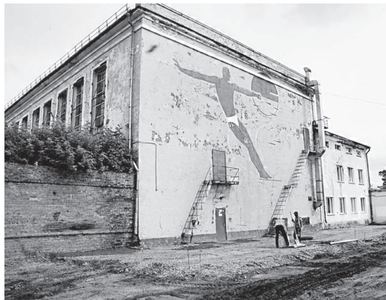
■ Никакого сайдинга и плит. Исторический облик, включая фрески с изображениями пловцов, будет сохранен
