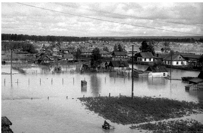
В августе 1953 года паводок в посёлке Китой окончательно разрушил деревянный мост через реку
