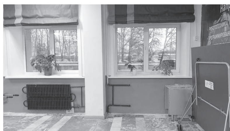
Полностью заменили входную группу, окна на первом этаже и частично на втором
